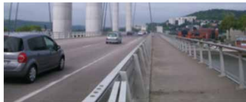
Photo 5 : Bande de service et d'exploitation du pont Flaubert (barrières BN4 et garde-corps)
