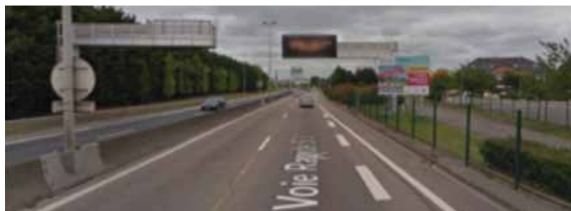
Photo 7 : Panneau à message variable localisé sur la voie rapide Sud III à l'amont du pont Flaubert (Google)
