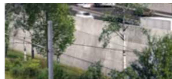
1 - Le monolithe : parois terre armée avec fruit 10°
