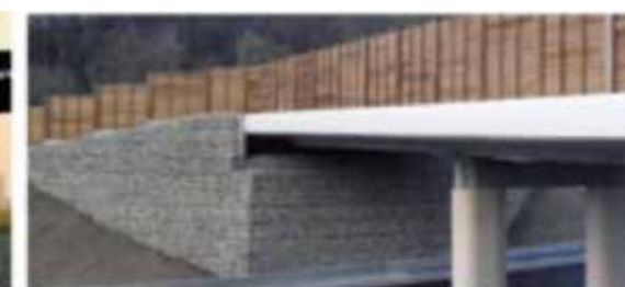
3 - Les culées en Terratrel avec fruit 30°
