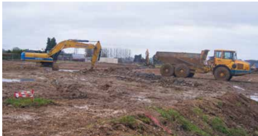
Photo 22 : Engins de chantier et travaux mécaniques susceptibles d'engendrer des dispersions de poussières (INGETEC)
