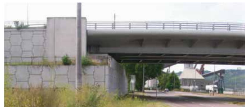
Photo 4 : Remblai en sol renforcé au niveau de l'appui de la culée Sud du pont Flaubert
