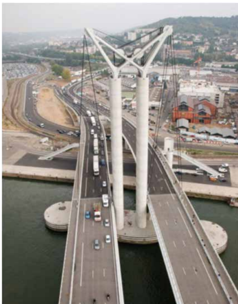
➤ Photo 3 : Vue du pont Flaubert depuis le pilier rive gauche
