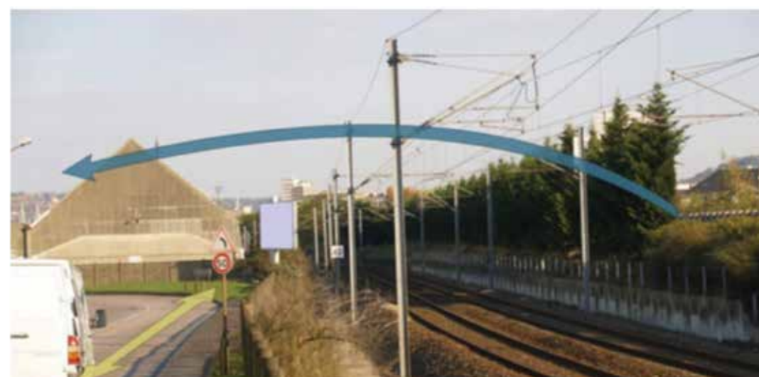
➤ Photo 24 : Franchissement des voies ferrées (CEREMA)
