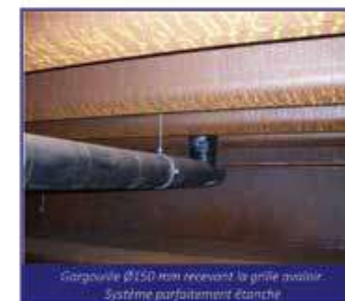
Photo 3(vues a et b) : Collecte des eaux de ruissellement dans le tablier levante
