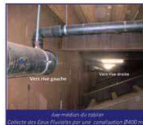
Photo 3(vues a et b) : Collecte des eaux de ruissellement dans le tablier levante
