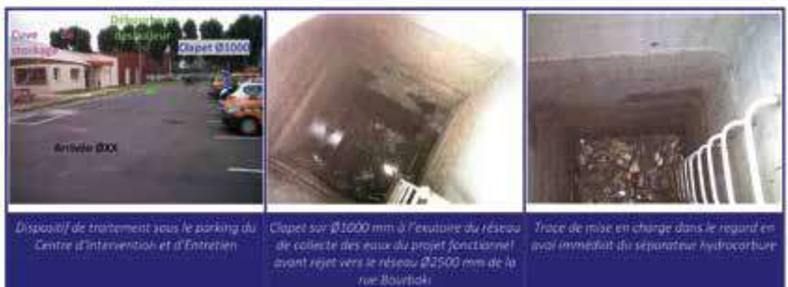
Photo 9(vues a, b et c) : Système de traitement au niveau du CEI
