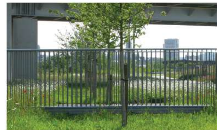
Clôture et portails barreaudée (type CNC)
