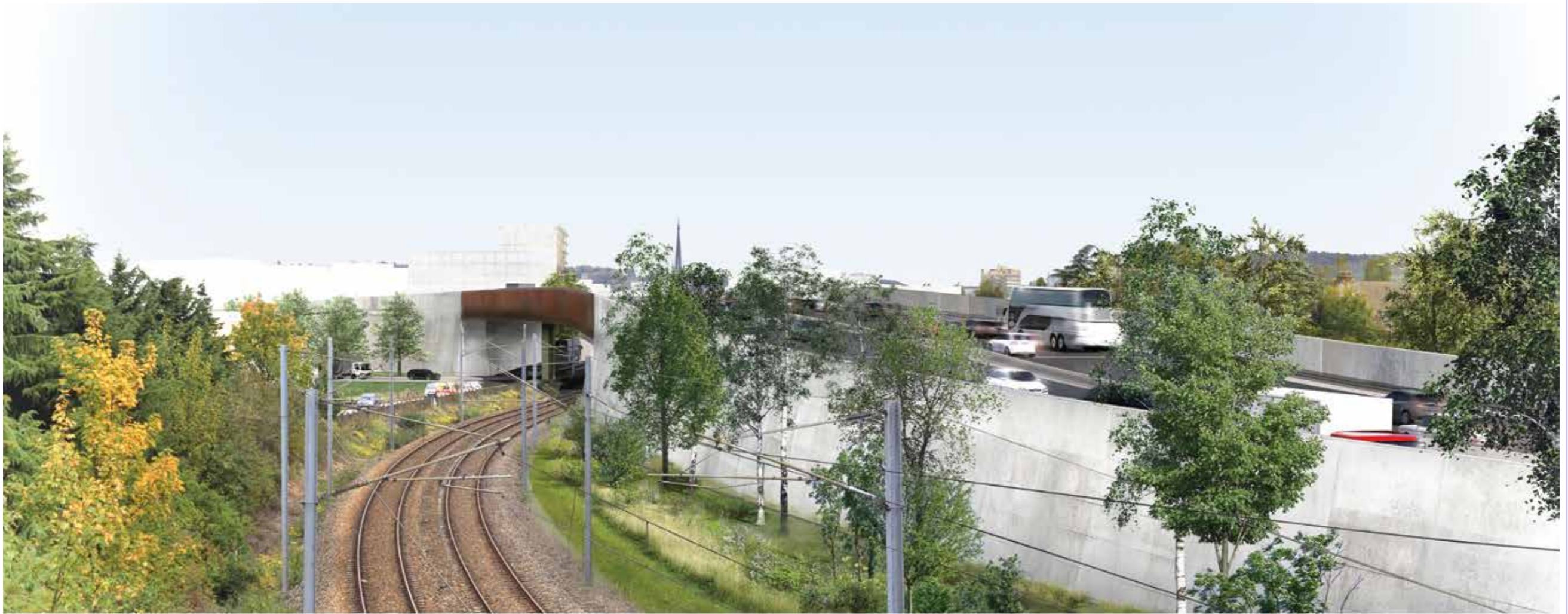
Vue sur le franchissement Pasteur depuis le faisceau ferré
