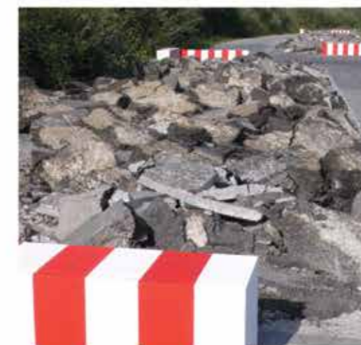
travail du sol et assise à l'approche de la route
