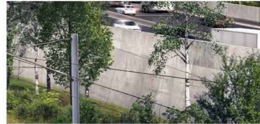
① le monolithe: parois terre armée avec fruit 10°
