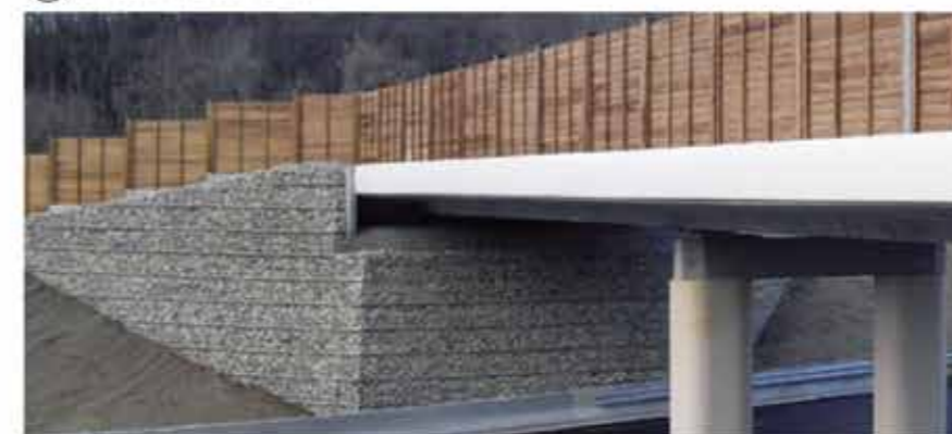
③ les culées en Terratrel avec fruit 30°
