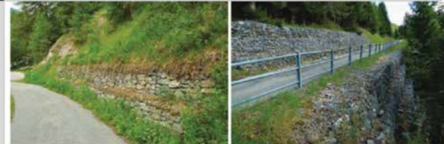
Gabions le long de routes (©Karch Centre de coordination pour la protection des amphibiens et des reptiles de Suisse)
