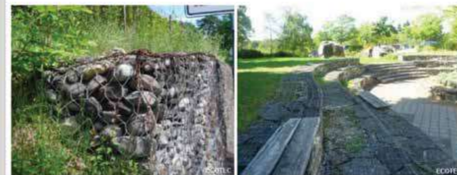
Exemples de gabions comme murs de soutènement et aménagement paysagers
