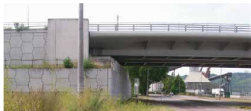
Photo 3 : Remblai en sol renforcé au niveau de l'appui de la culée Sud du pont Flaubert
