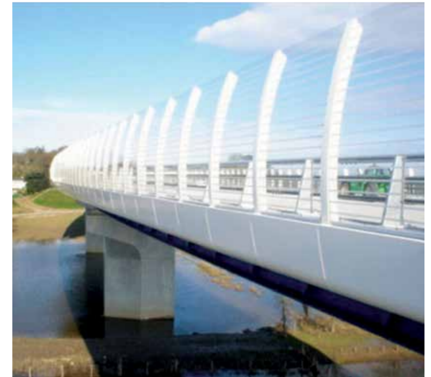
Photo 5 : Exemple d'écran acoustique doublé d'un équipement de retenue de niveau H2
