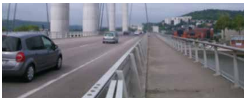
Photo 4 : Bande de service et d'exploitation du pont Flaubert (barrières BN4 et garde-corps)
